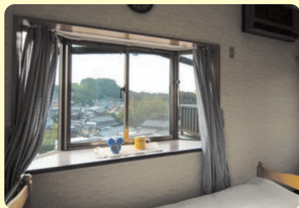
アタッチメントを使ってガラス交換した踊り場の窓。本来の枠の内側にもうひとつ化粧枠が入ったように見える
