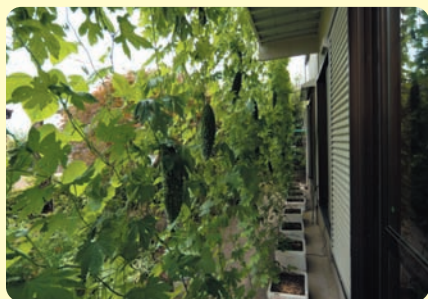
夏の直射日光と熱気はまず緑のカーテンである程度遮られ、その後エコガラスの窓でシャットアウトされる
