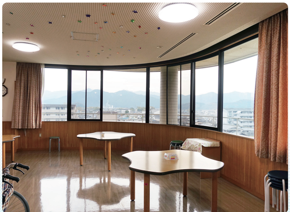
食堂兼談話室兼ダイニングの空間は南西方向にカーブした窓を持ち、篠山の山々が眺められる。中央の曲面ガラスは熱線吸収ガラスで、これのみエコガラスへの交換を見送った
